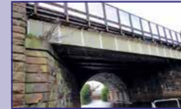
Longitudinal Plate Girders
